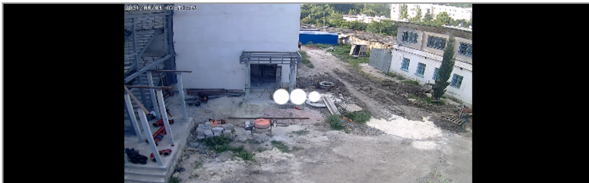
Строительство физкультурно-оздоровительного комплекса открытого типа (ФОКОТ) ул. Петра Ситникова, 3 кам 4
