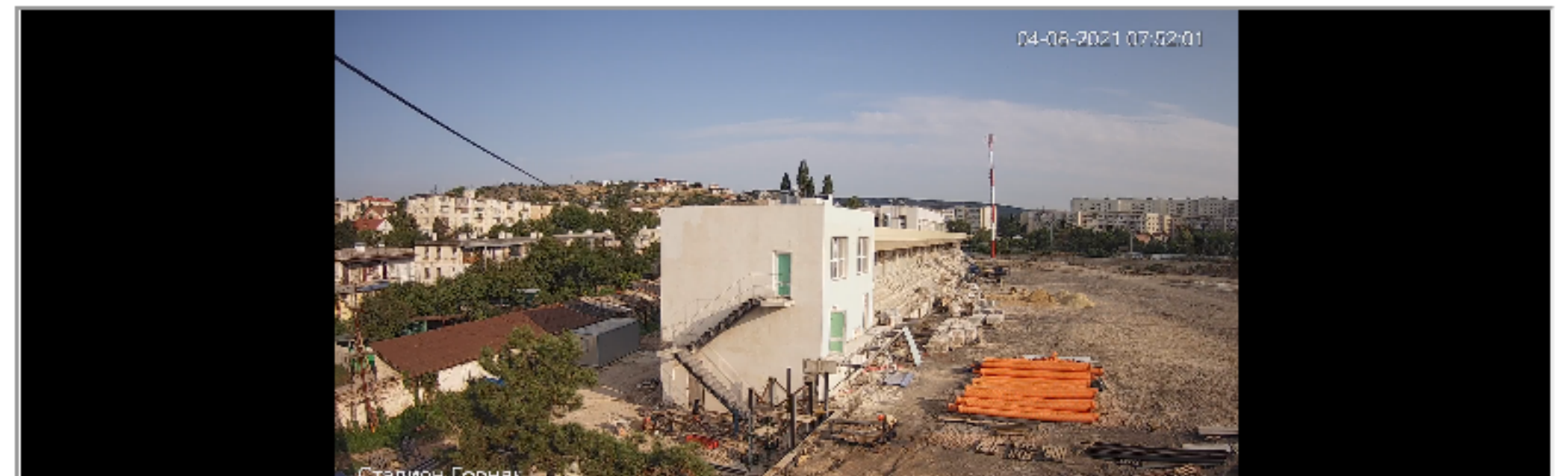
Строительство физкультурно-оздоровительного комплекса открытого типа (ФОКОТ) ул. Петра Ситникова, 3 кам 3
