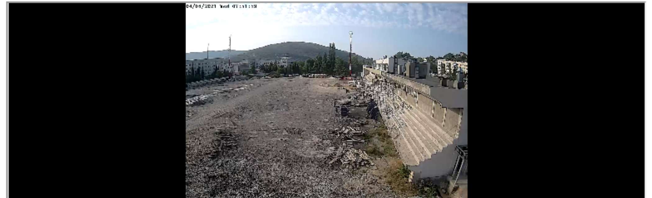
Строительство физкультурно-оздоровительного комплекса открытого типа (ФОКОТ) ул. Петра Ситникова, 3 кам 2
