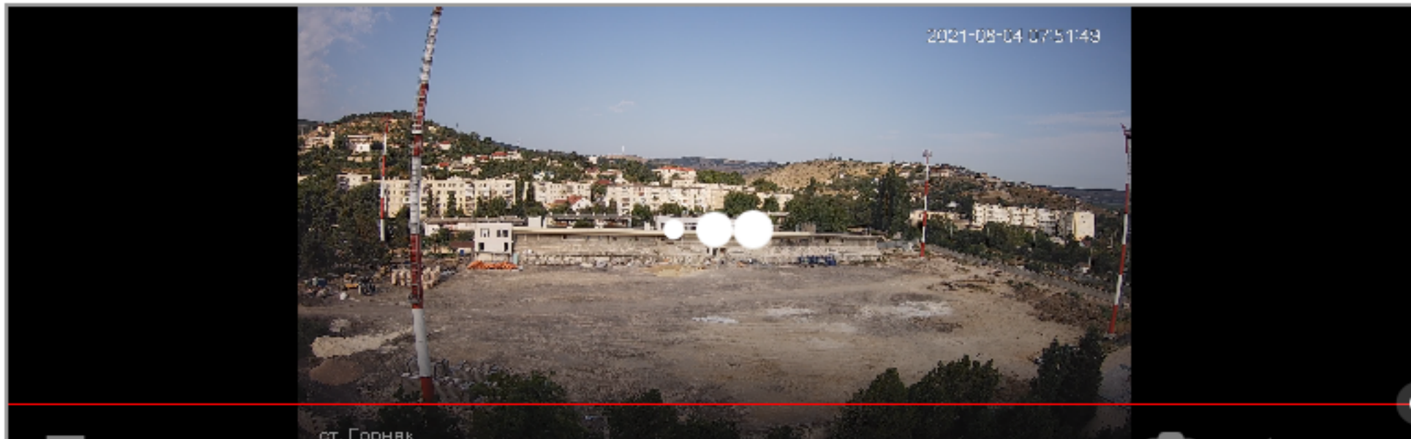
Строительство физкультурно-оздоровительного комплекса открытого типа (ФОКОТ) ул. Петра Ситникова, 3 кам 1
